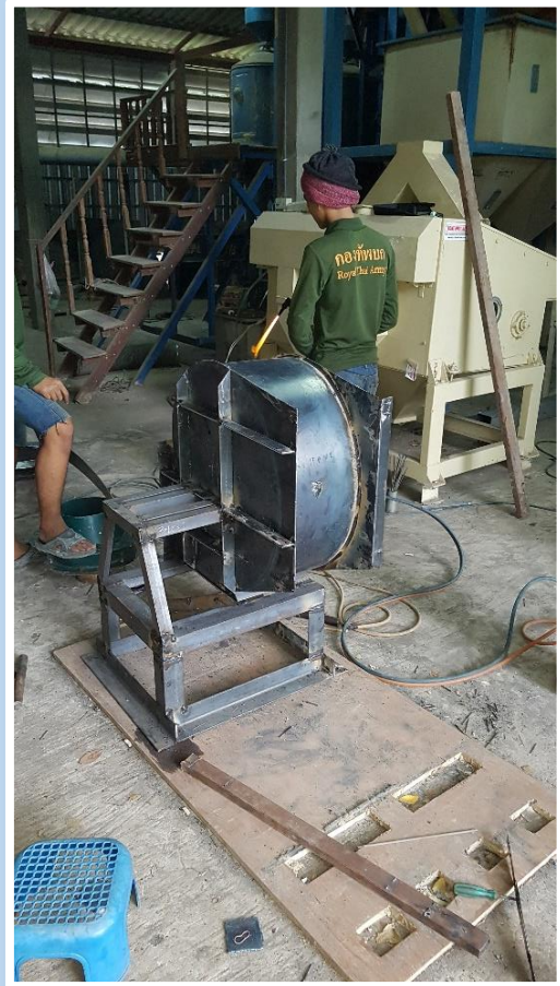
การปรับปรุงโรงสี ติดตั้งพัดลมทำความสะอาดใหม่ ตั้งกระพ้อ ส่วนขัดขาวใหม่
