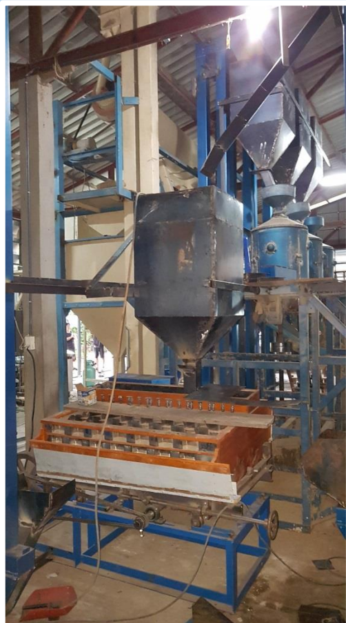
การปรับปรุงโรงสี ตั้งเครื่องทำความสะอาดข้าวเปลือกใหม่ กระพ้อขนถ่ายข้าวในโรงสี ติดตั้งตู้สี่มีटरระบบปิดใหม่ ติดตั้ง เครื่องคัดแยกข้าวเปลือกข้าวกล้องใหม่
